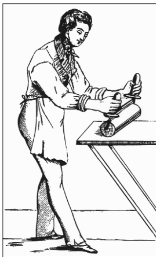
Manuelles Einfärben mittels Handwalze. Aus F. W. Hasper: Handbuch der Buchdruckerkunst , 1835.
