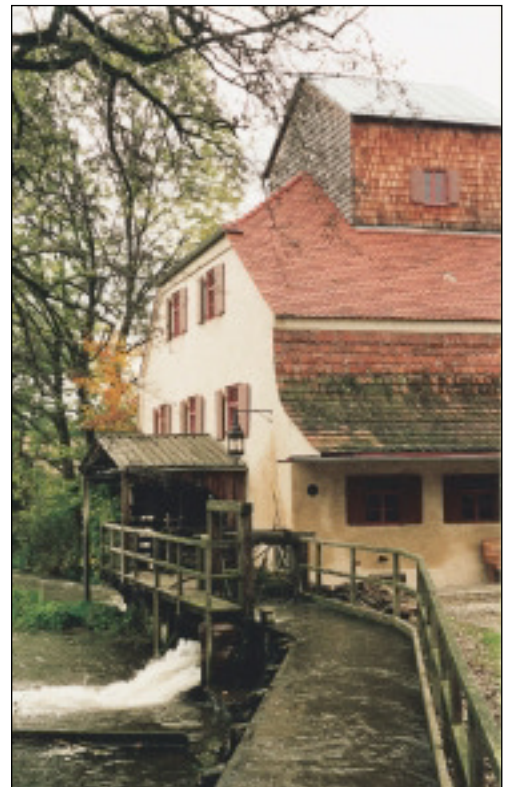
Das historische Mühlengebäude mit mittelschlächtig beaufschlagten Mühlrad und Zulauftrinne vorn. Foto: Boris Fuchs
